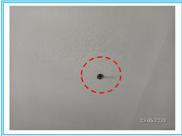
รูปที่ 3.1-17 หัวกระจายน้ำดับเพลิง
