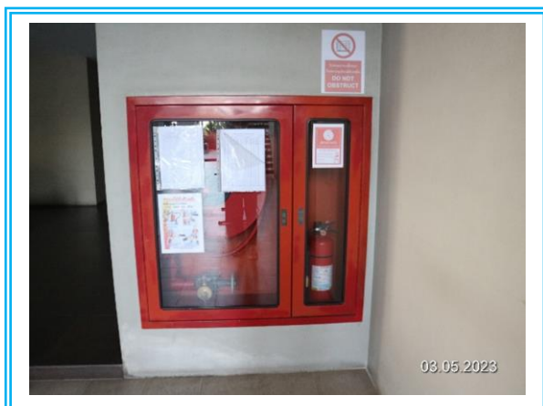
รูปที่ 3.1-15 ตู้เก็บอุปกรณ์ดับเพลิง
