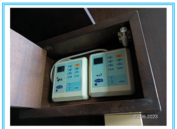
รูปที่ 3.1-34 การติดตั้งสวิตช์เปิด/ปิดเครื่องปรับอากาศ แยกออกจากกันในแต่ละพื้นที่ของอาคาร
