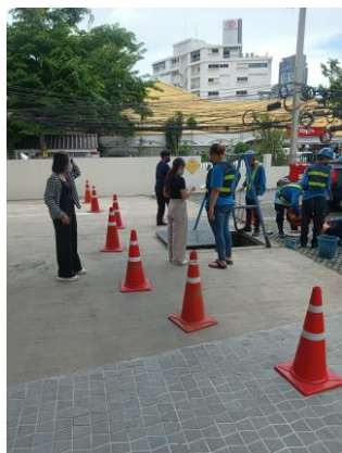
รูปที่ 3.1-43 ขุดลอกตะกอน และทำความสะอาดบ่อพักน้ำทิ้ง
