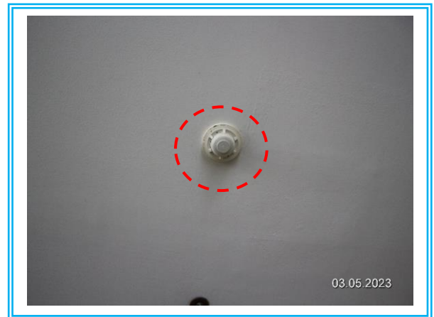
รูปที่ 3.1-20 Heat Detector
